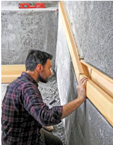
Max Lunow baut die Handläufe für die Treppengeländer ein. Quelle: Franziska Mohr
