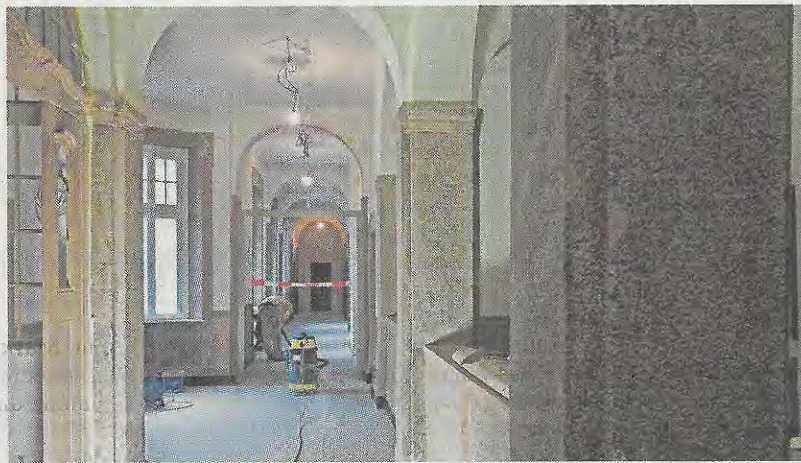
Im Altbau des Amtsgerichts wurde der Steinputz aufwendig wieder freigelegt.
