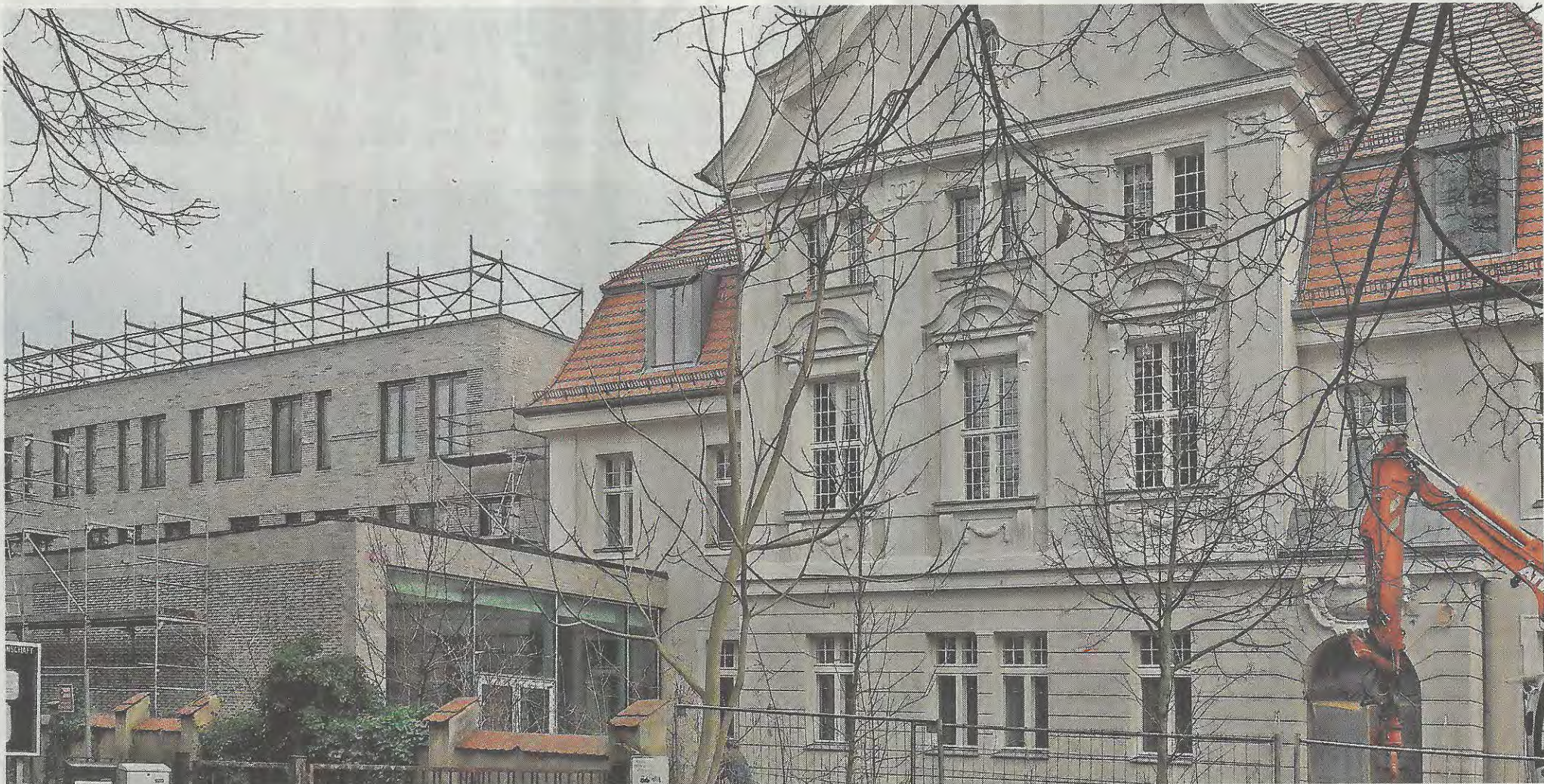
Blick auf das neue Eingangsfoyer des Amtsgerichts Königs Wusterhausen.
